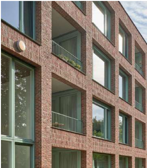
balcon en maçonnerie et borrotins
