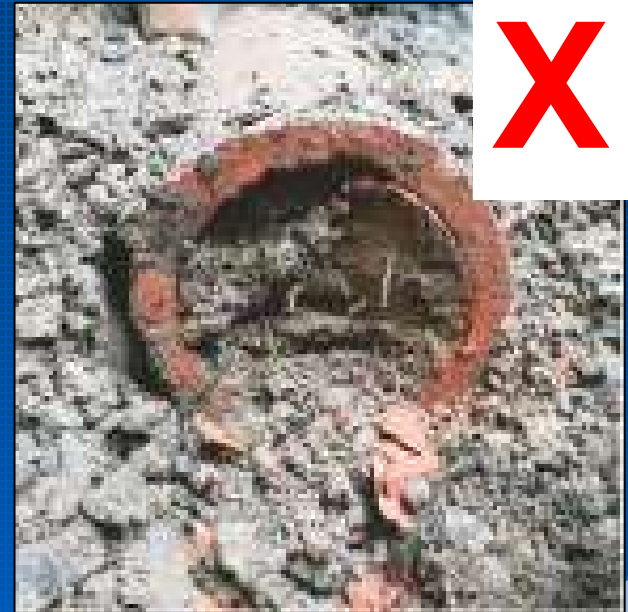
Drain de fondation obstrué
